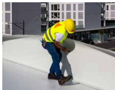
3. Bevestig het zelfklevende membraan.
