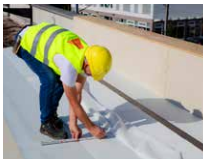
2. Teken de bovenkant van de opstand af.
