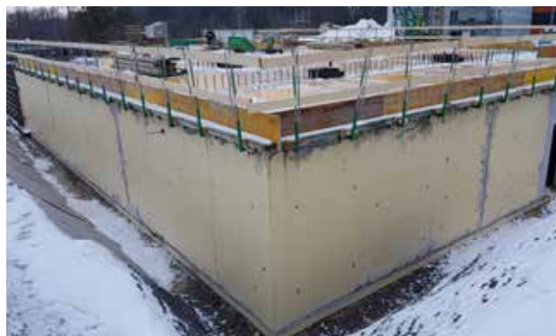
Open uitgraving met SikaProof® A+ : na het verwijderen van de bekisting moeten ankeropeningen afgedicht worden.
